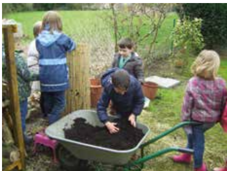
Beim Bau des Kartoffelturms
